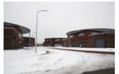
Wonen boven het bedrijf op het WFO terrein
