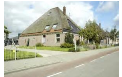
De voorgevel heeft een rijker karakter dan de zij- en achtergevel
