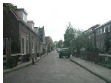
Smalle straten met lage goten en vrijwel aaneengesloten bebouwing
