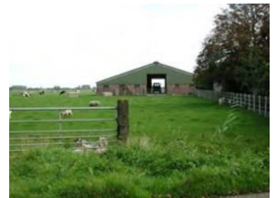
Een horizontale geleiding in de kopgevel
