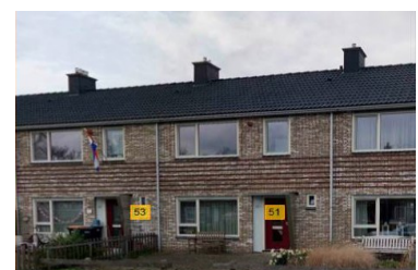
Samenhangende materialen en kleuren na isolatie van de gevel
