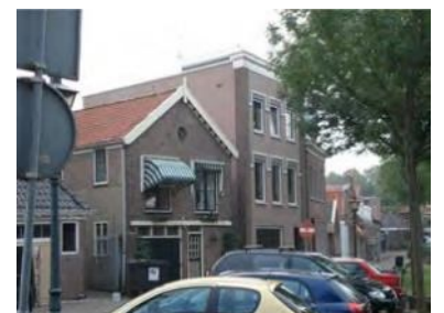
Ondanks de historische referenties valt het hogere gebouw uit de toon qua massa en architectonische uitwerking
