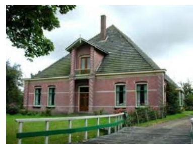
Een representatieve gevel met siermetselwerk en een dubbelhoge entree
