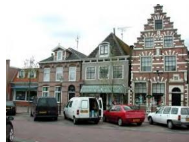
Dakkapellen in de goot als onderdeel van de architectuur van de voorgevel
