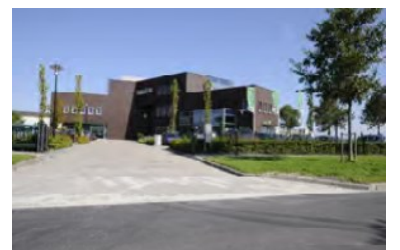
Recente bouw met een representatieve architectuur
