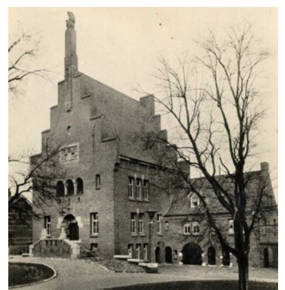
Naast het oude Stadhuis is ruimte voor nieuwbouw die het historisch stadsdeel moet versterken (de rechtervleugel was al eerder gesloopt).
