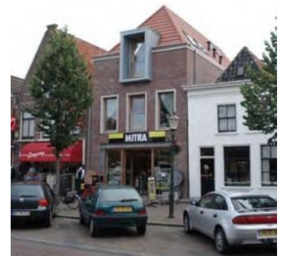
Het gebouw past in maat en schaal goed in de straatwand, maar laat te wensen over in de verdere uitwerking en de architectonische verhoudingen
