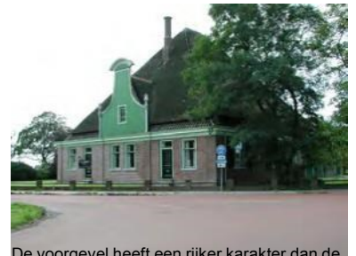
De voorgevel heeft een rijker karakter dan de zij- en achtergevel
