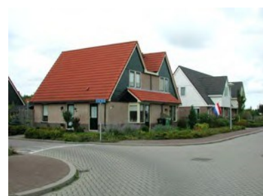
Individuele woningbouw als ensemble in een wijk met vrije verkaveling
